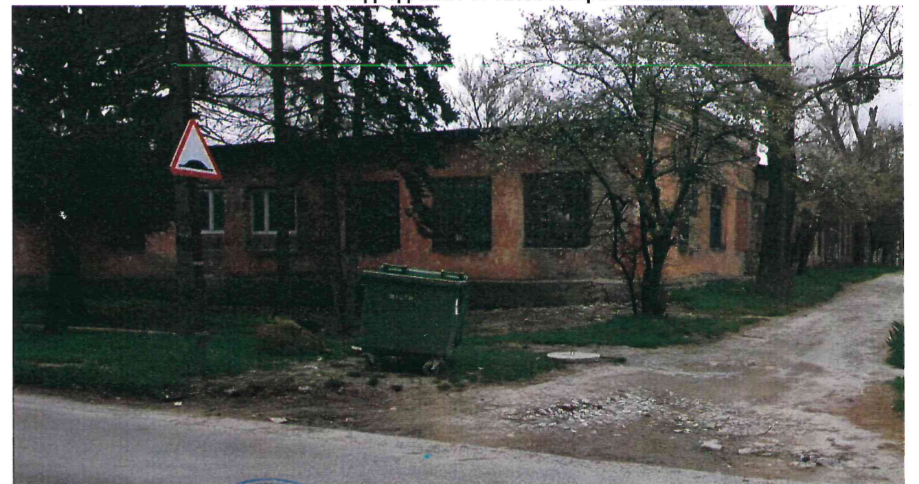
ВНЕШНИЙ ВИД ЗДАНИЯ В НАСТОЯЩИЙ МОМЕНТ
